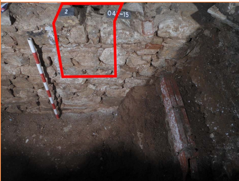
Foto 8. Vista de detall de l'estructura UE 2 amb la zona afectada assenyalada amb guix, i ressaltat.
